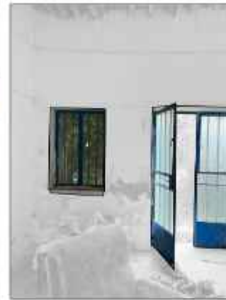
3. Αποκατάσταση θύρας και παραθύρων με μεταλλικά
