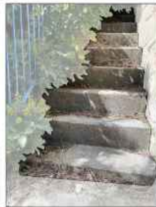
4. Χρωματική φθορά σιδέρου σκάλας και ριγματώσεις στα σκαλοπάτια
