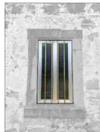
5. Αποκατάσταση παραθύρου με παράθυρο αλουμενίου
