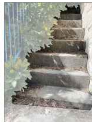
6. Επικάλυψη εξωτερικής σκάλας με λεπτή στρώση τσιμέντου & βάψιμο του σιδέρου της σκάλας
