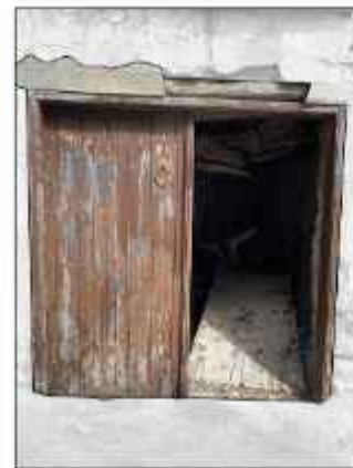
2. Επικάλυψη ανωφλίου με στρώση σκυροδέματος
