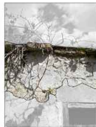
4. Επικάλυψη τοιχοποιίας με επίχρισμα
