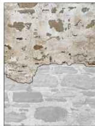
3. Επικάλυψη τοιχοποιίας με επίχρισμα
